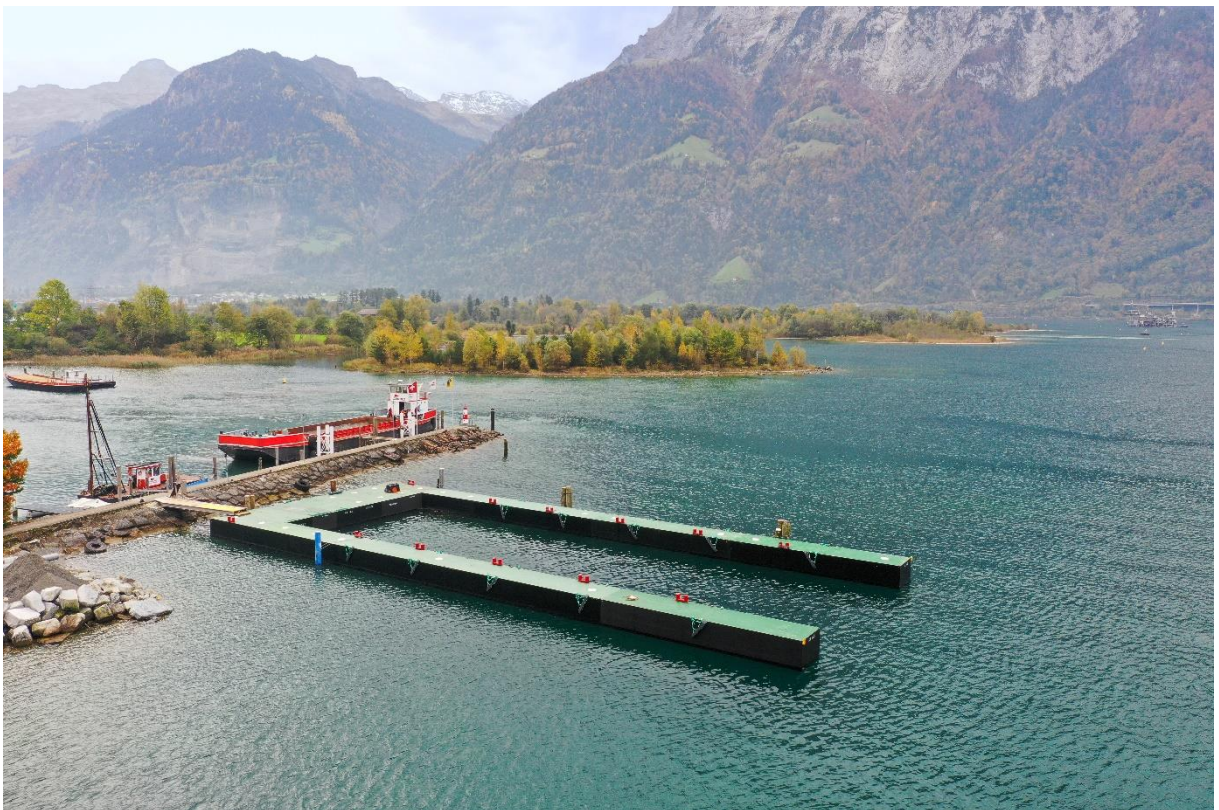
Bild 2: Die Pontonanlage, die zum Schutz vor Trübung zum Einsatz kommt, wird derzeit im Industriehafen Flüelen aufgebaut. (Blick Richtung Schüttgebiet)
