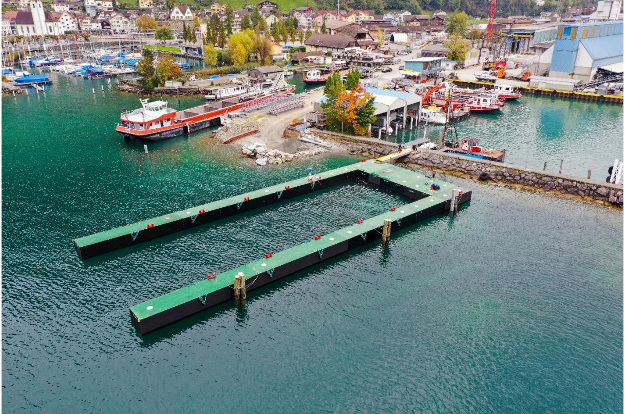
Bild 1: Die Pontonanlage, die zum Schutz vor Trübung zum Einsatz kommt, wird derzeit im Industriehafen Flüelen aufgebaut. (Blick Richtung Flüelen)
