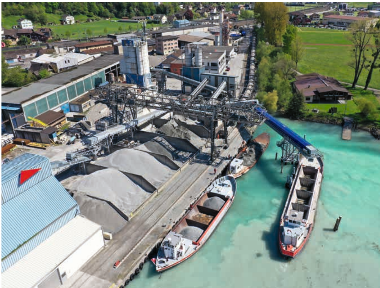
Vom Gotthard her wird das Gestein per Bahn zum Industriehafen in Flüelen transportiert und dort auf die Schüttschiffe verladen.
